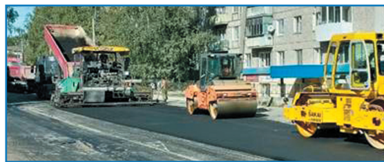
Ремонт автодорог местного значения, в том числе в г. Сортавала, г. Кемь, пгт Калевала (20 км на сумму 160 млн руб.)
