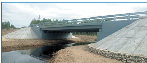
Строительство мостового перехода на км 34 + 350 автодороги Сумпосад – Воренжа – Вирандозеро – Нюхча
