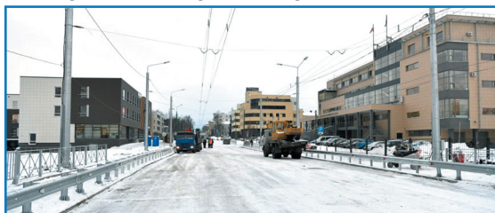
Реконструкция моста через реку Неглинка по улице Кирова в г. Петрозаводске
