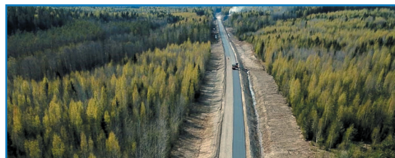
Строительство автомобильной дороги Великая Губа – Оятевщина протяженностью 31,3 км
