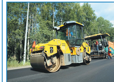
Отремонтировано 184 км региональных дорог и более 24 км дорог в г. Кондопоге и г. Петрозаводске в рамках НП «БКД»
