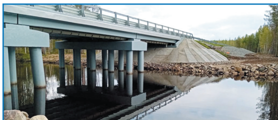
Строительство мостового перехода на км 16 + 500 автодороги Сумпосад – Воренжа – Вирандозеро – Нюхча
